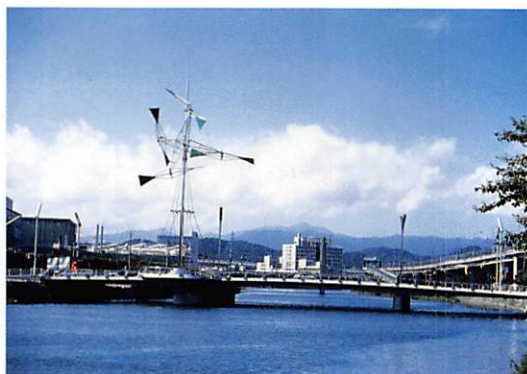
中島橋（風の橋）
