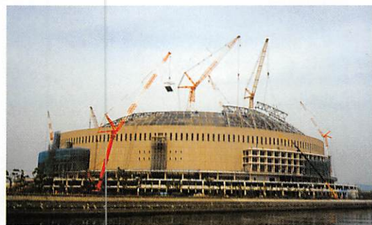
屋根鉄骨建方中のドーム
