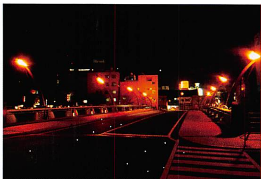
室町大橋（火の橋）
