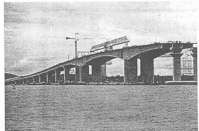
シンガポールとマレーシアを結ぶ橋梁の工事現場
