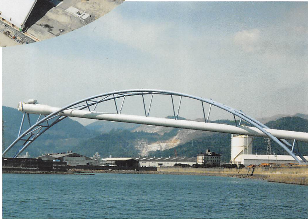
刈田発電所揚炭設備海上横断橋
