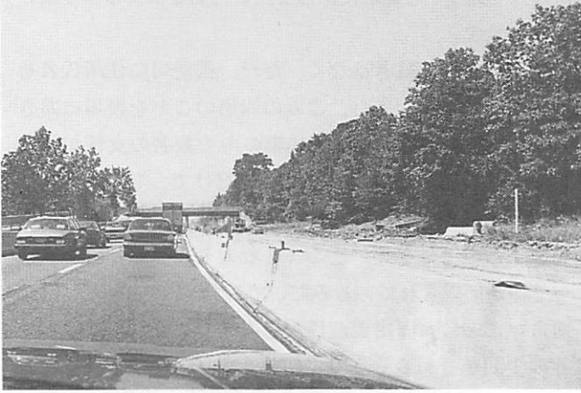
Highwayのコンクリートガードフェンス
