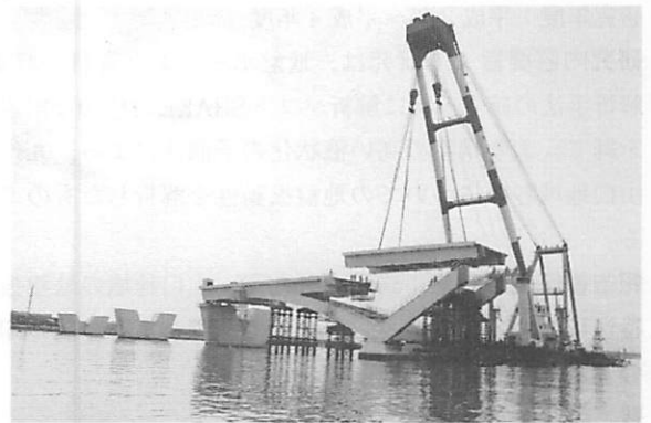
架設状況(起重機船によるブロック架設)
