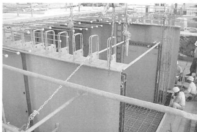
波形鋼板設置状況
