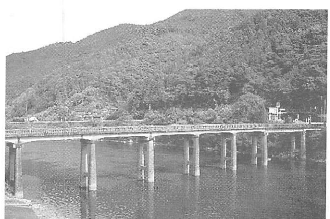
写真26 神瀬橋 (熊本県 1934)
