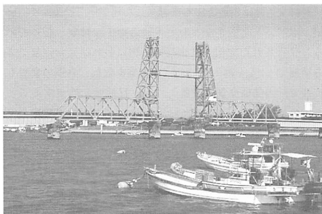
写真5 筑後川昇開橋（福岡県 1935）
