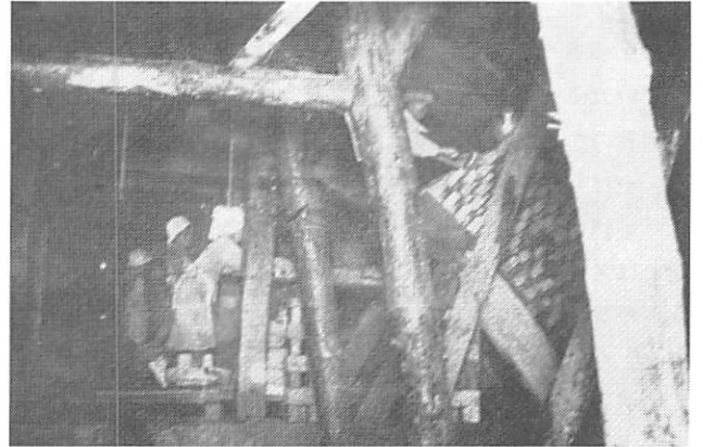
写真-4 炭滓線アーチ部の煉瓦積み作業
