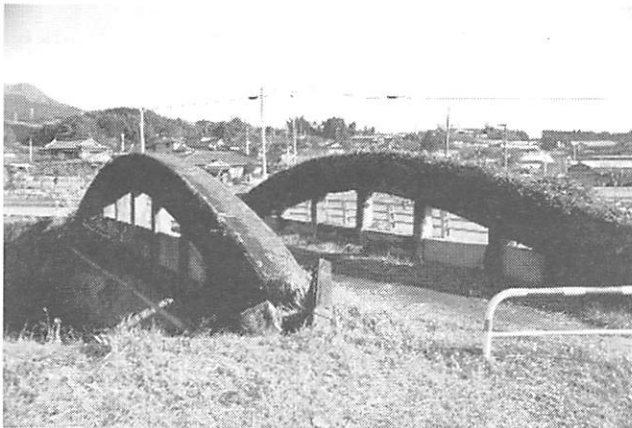
写真15 姫井橋(熊本県 1925)
