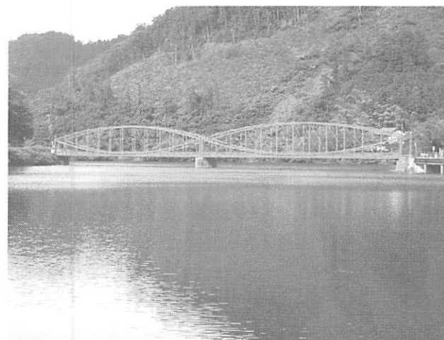
写真-11 南河内橋全景
