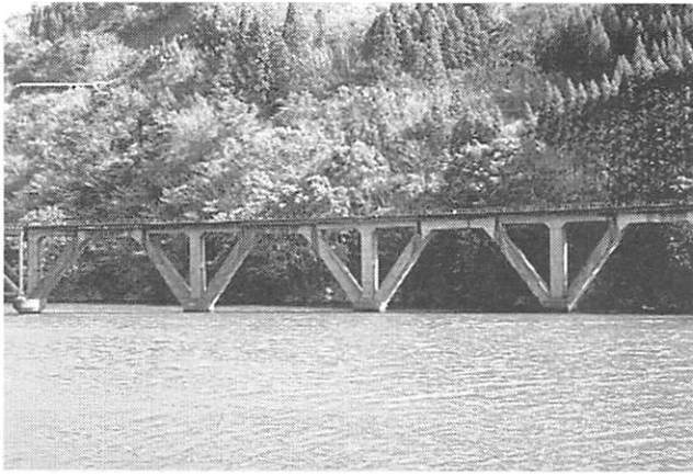
写真19 五ヶ瀬橋梁（宮崎県 1937）
