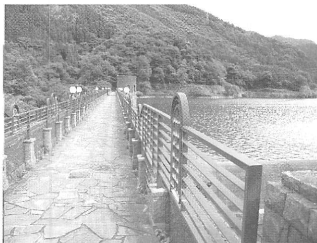
写真-10 河内ダム堰堤上部
