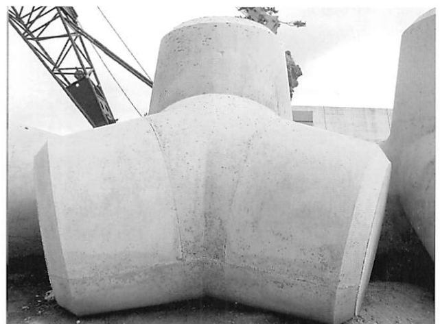
写真二 転炉スラグを骨材とした消波ブロック
