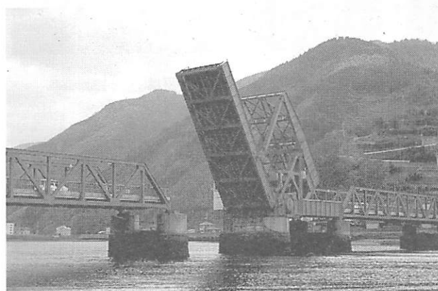
写真6 長浜大橋（愛媛県 1935）
