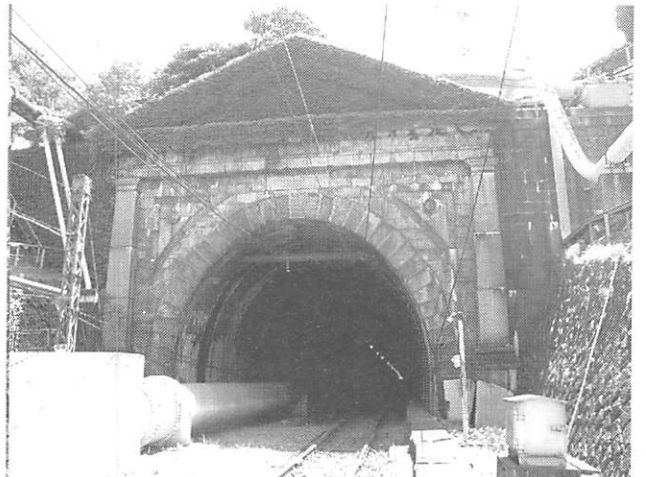
写真-5 現在の八幡側洞門
