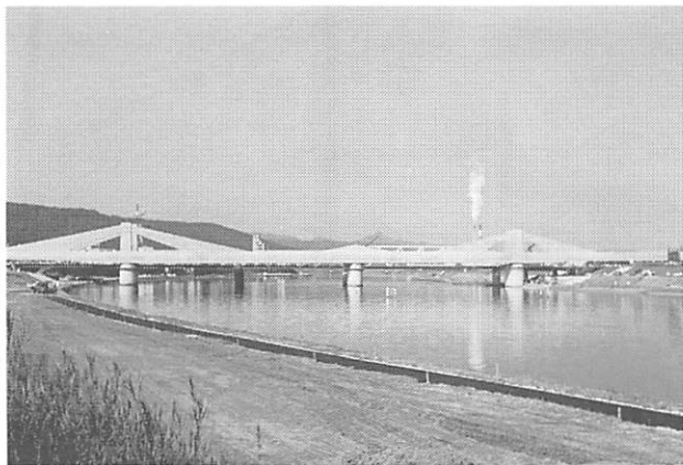
写真一 4 川内川橋梁
