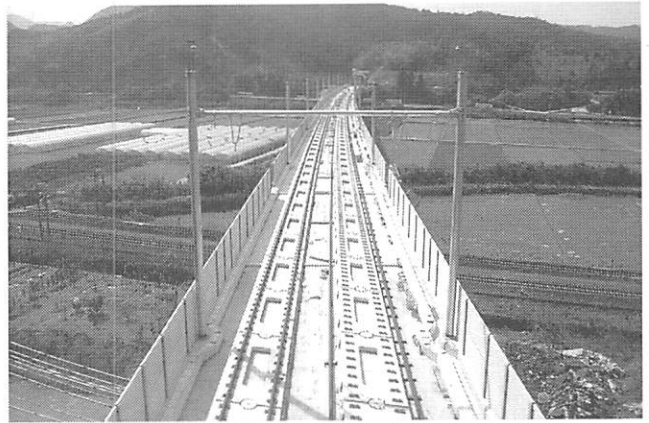
写真一 6 枠形軌道スラブ敷設
