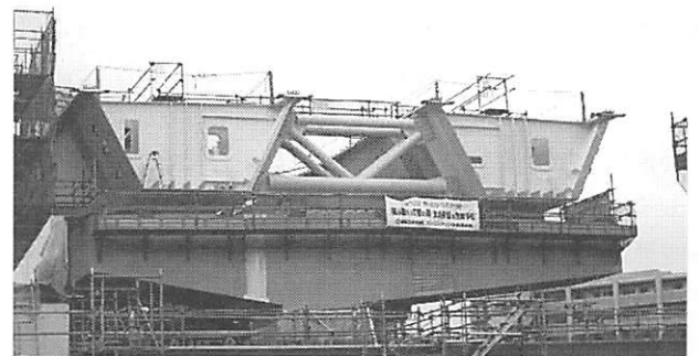
写真-1 現地架設状況
