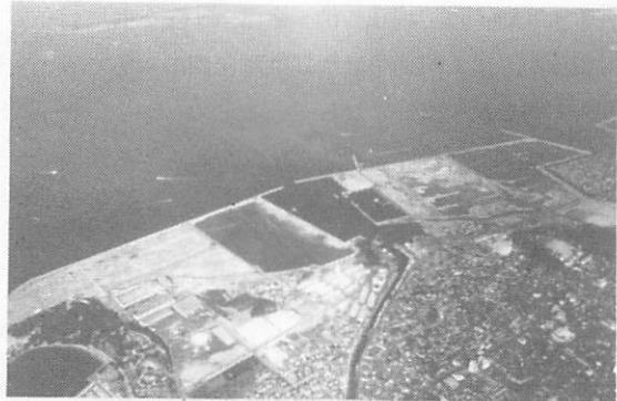
小戸・姪浜地区埋立工事
