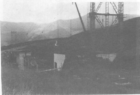
九州横断自動車道 並柳橋
