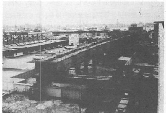
桁組立状況（地組横取工法）
