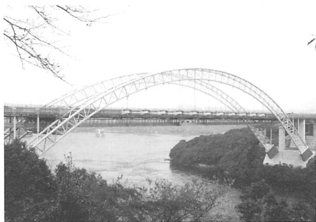
写真2 鋼中路ブレースドリブアーチ橋
