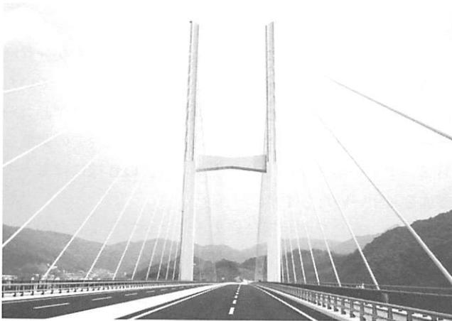
写真4 女神大橋主塔および橋面状況
