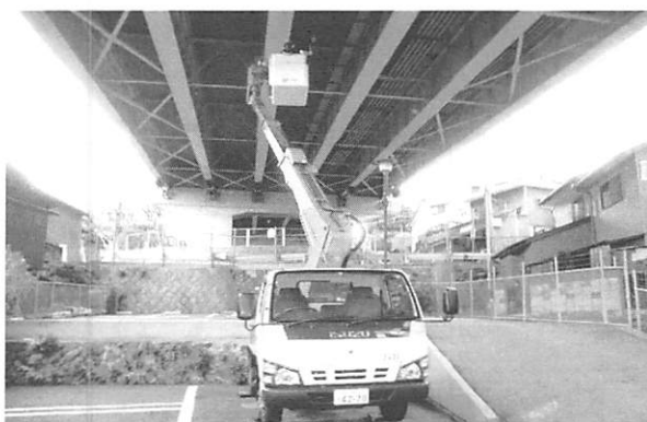
橋梁点検状況
