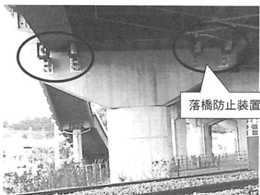
耐震補強状況（写真）
