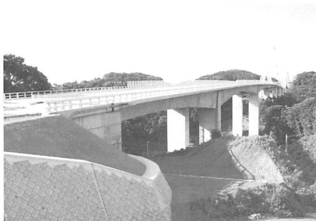
写真3 4径間連続PCラーメン橋
