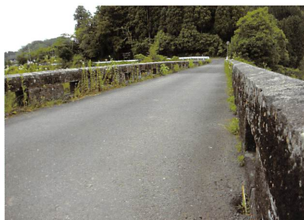
橋面（高欄の高さは低い）
