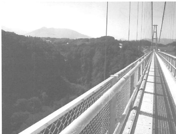
写真-3 九重 " 夢 " 大吊橋 (橋上から)
