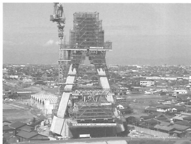
写真1 矢部川橋P1主塔からP2主塔を望む
