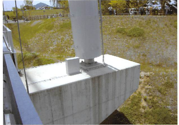
写真-2 主塔基部（ピン）
