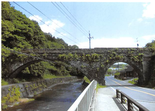
若宮井路鏡水路橋全景
