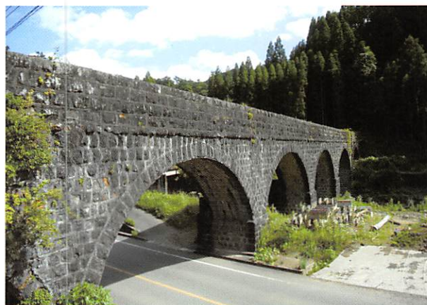
明正井路一号幹線一号橋全景
