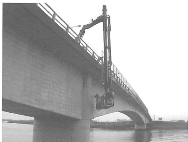
写真-1 橋梁点検車
