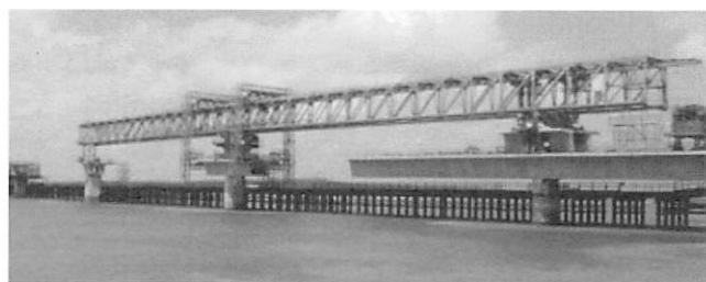
セグメント BL の架設状況
