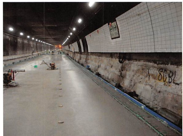
写真-5 FRP 床版の設置の状況
