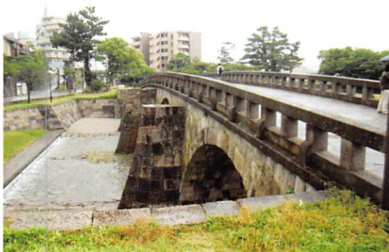
移設・保存された高麗橋
