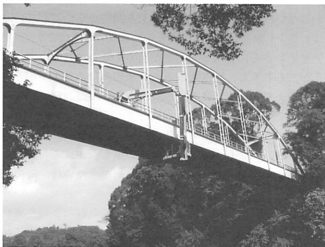
写真-1 弊社の橋梁点検実施状況
