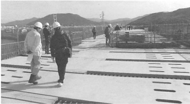
図-1. 松浦川大橋
