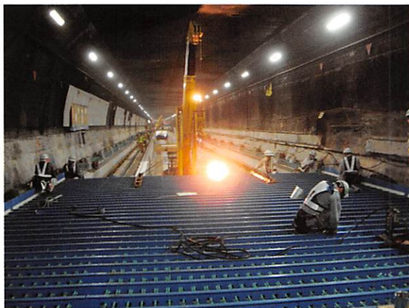
写真-4 FRP 床版の設置の状況
