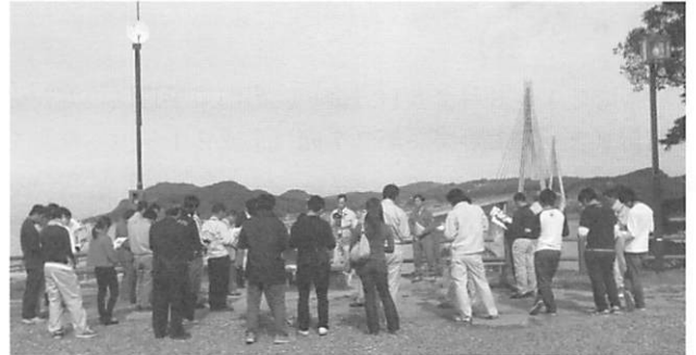
図-2. 鷹島肥前大橋
