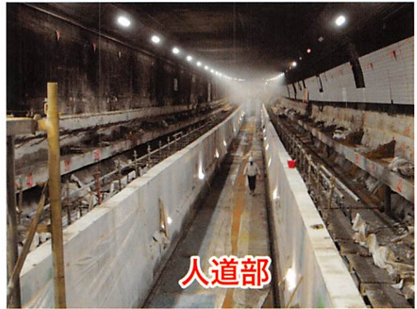
写真-3 床版の撤去後の状況
