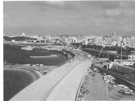
A1より全体を臨む (手前の完成済みの区間がA1-P8)
