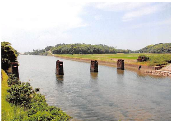
浜田橋の下流に残るレンガ造の橋脚
