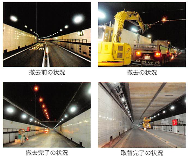
写真-1 天井板の施工状況写真
