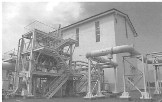
山川発電所建屋全景
