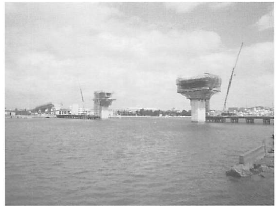
柱頭部施工状況
