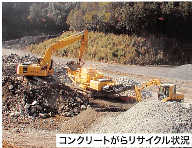
写真-8 コンクリートがらリサイクル
