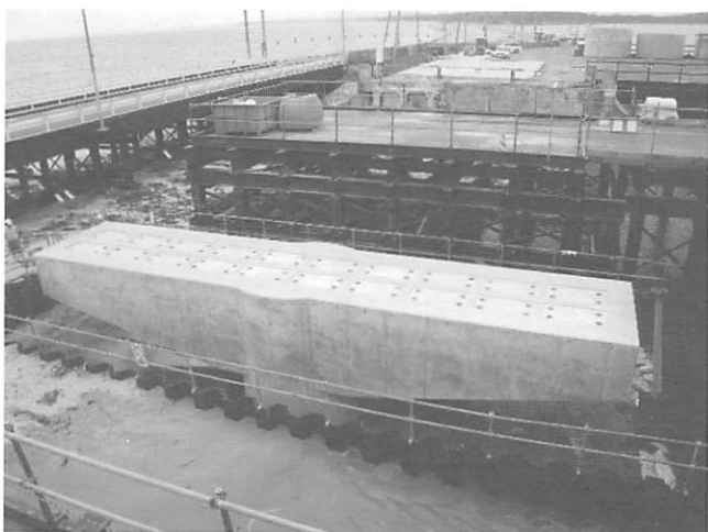
P1橋脚完成
