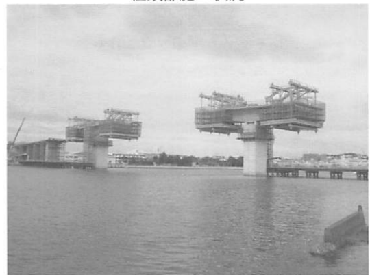
張出し架設状況
