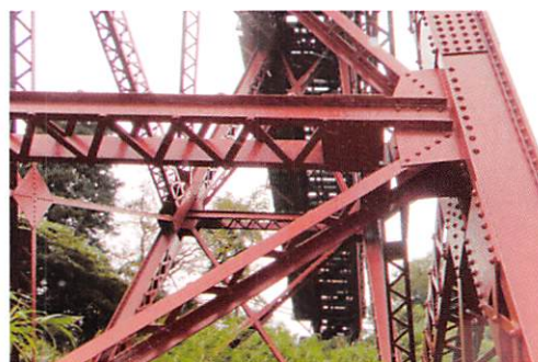
立野橋梁の鋼材の状況
