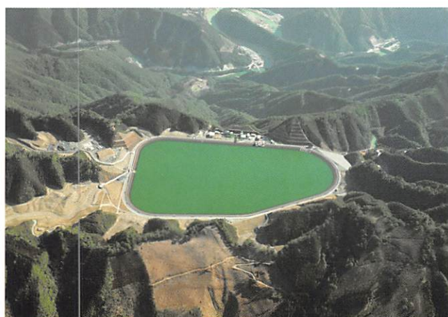
写真-2 上部ダム・調整池
