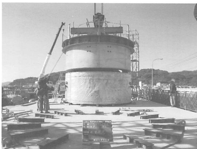
プレキャストブロック製作状況
