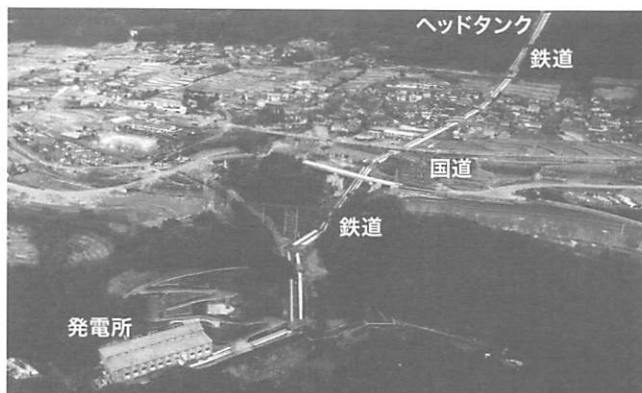
写真-1 黒川第一発電所水圧鉄管全景
