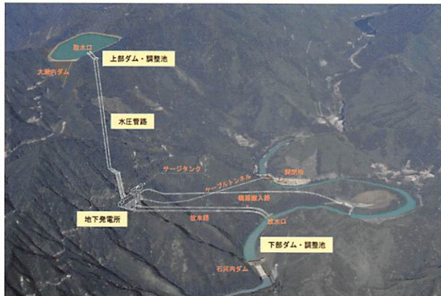
写真-1 小丸川発電所 全景
