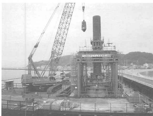
拡翼掘削状況
