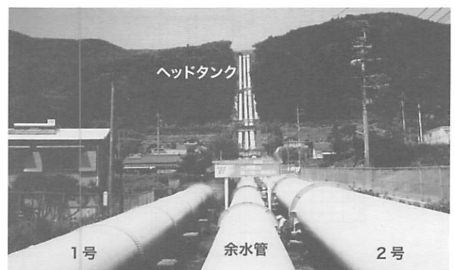
写真-2 黒川第一発電所水圧鉄管近景
