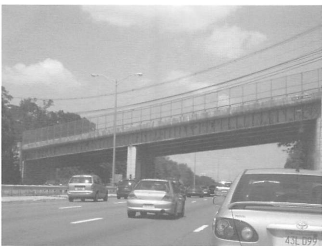
図-8 高速道路に架かる橋梁
