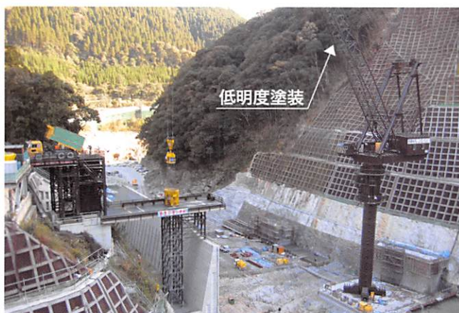
写真-5 下部ダム 工事状況
