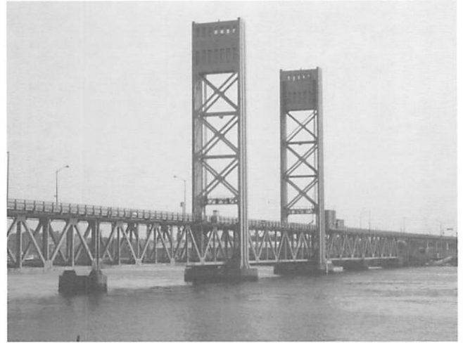
図-11 国道1号線の橋梁
