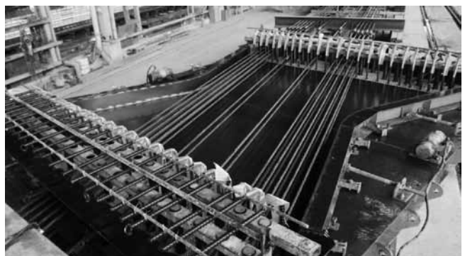
写真-1 PC鋼材の配置状況
