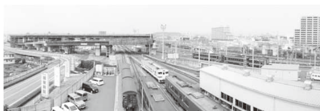
ベント・軌条設備
