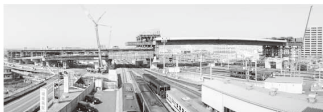
本橋送出し完了降下前
