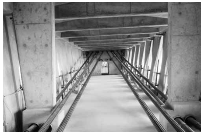
写真-4 閉合後の外ケーブル緊張完了状況
