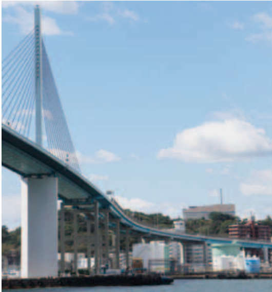
写真-1 荒津大橋
