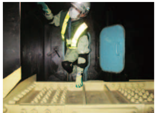
写真-2 箱桁内の移動状況
