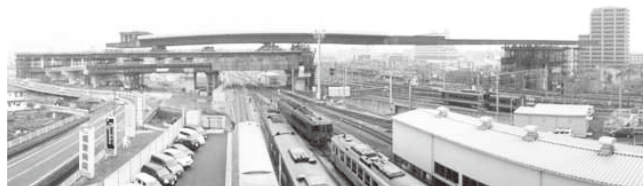
手延機・本橋送出し中
