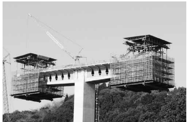
写真-2 張出し架設状況
