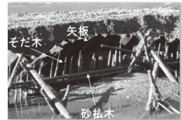
写真-6 牛棗工の状況
