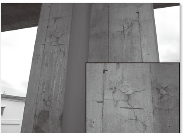
写真-2 海砂に含まれる反応性珪物による遅延膨張性 ASR
