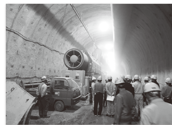
写真-4 久山トンネル坑内
