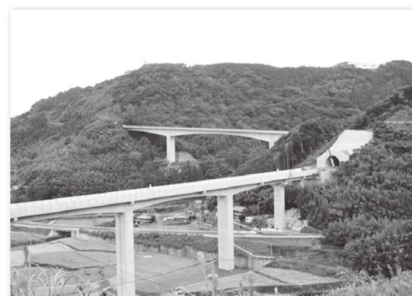
写真-1 千綿川橋梁
