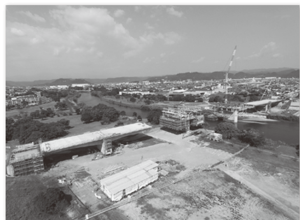
写真-6 張出し架設状況
