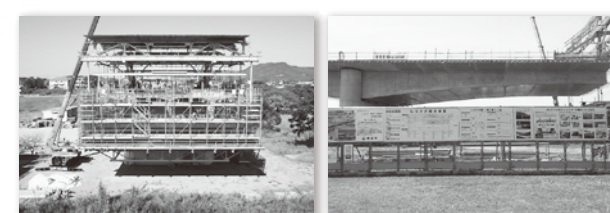
写真-1 大型架設作業車 写真-2 完成予想図等
