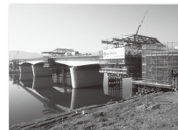
写真-4 平成28年3月上旬進捗状況
