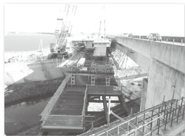
写真-1 架設状況
