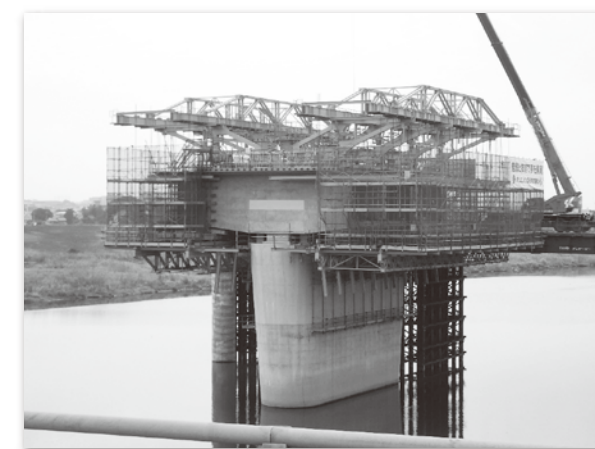
写真-1 施工状況
