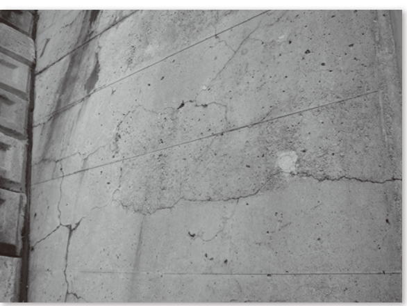
写真-3 石灰岩に貫入した火成岩による ASR
