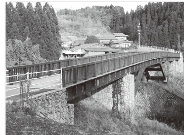
写真-1 県道の側道橋(大分県)
