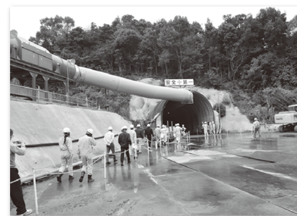
写真-3 久山トンネル側坑口付近
