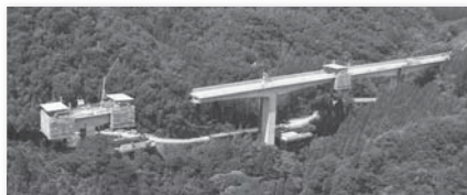
写真-1 現場進捗状況
