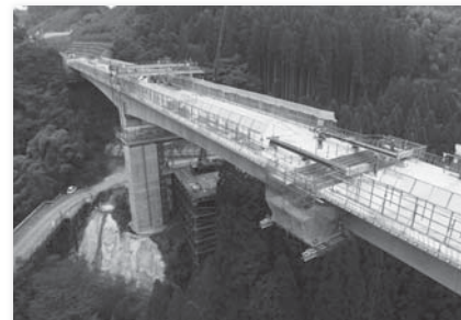
写真-3 中央閉合部施工状況
