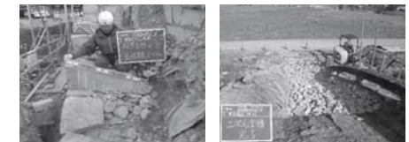
(a)壁石の控え長さ (b)中詰め工
