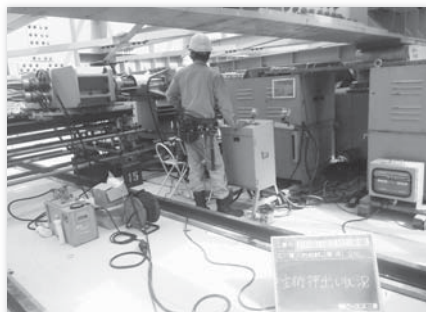
押し出し装置(反力集中方式)
