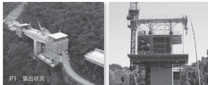
写真-2 張出架設状況(P1)
