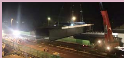
Lランプ二号橋の架設状況
