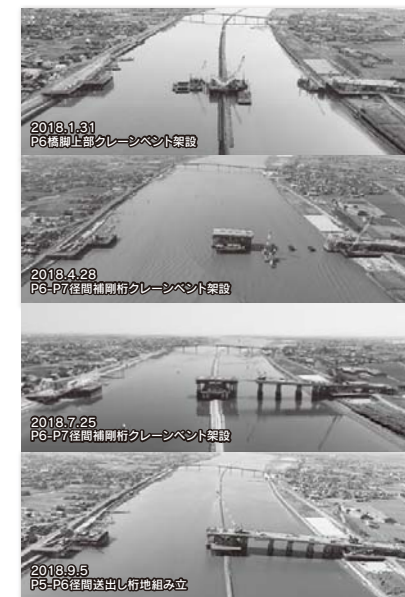
図-2 現地架設状況全景
