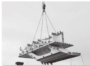
写真-1 海上輸送船積み状況写真 (P4橋脚スプリング部)
