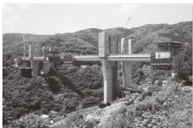
写真-1 施工状況全景
