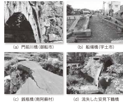
写真-7 被災した石橋の補修と流失した橋
