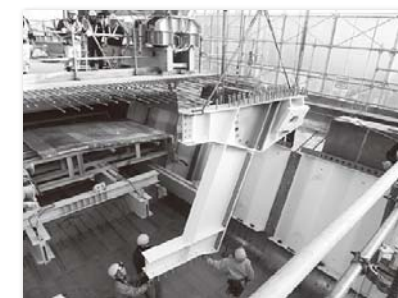
写真-3 鋼板リブ部材の架設
