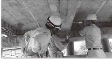
写真一5 実習状況
