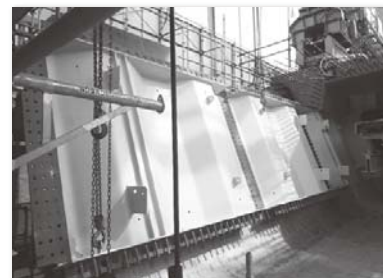
写真-2 波形鋼板ウェブの架設
