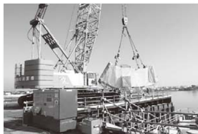
写真-2 海上輸送陸揚げ状況写真 (P4橋脚スプリング基部)
