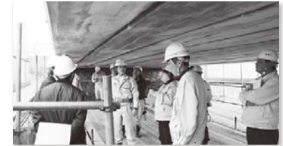
写真一9 橋梁視察状況
