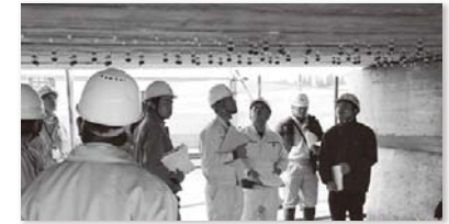
写真一8 橋梁視察状況
