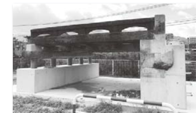
写真-4 実習橋(1958木ノ下橋)
