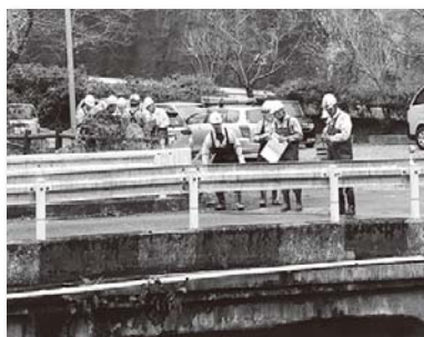
写真-2 フィールドワーク(点検実習) 状況
