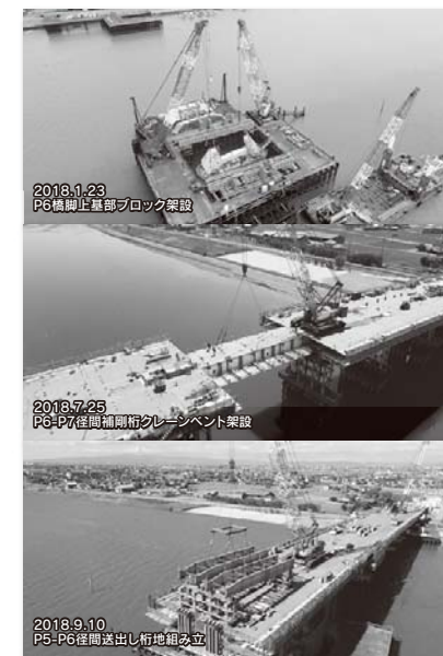
図-3 現地架設状況
