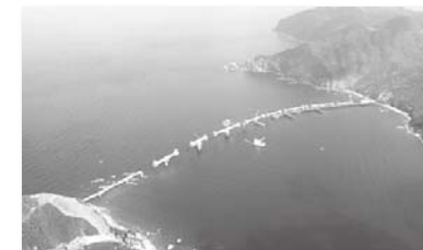
写真-1 平成31年1月末進捗状況
