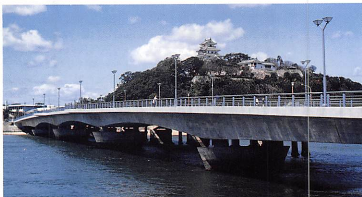
▲舞鶴橋(佐賀県) [唐津市のシンボル唐津城の眼下に新しく架け替えられた5径間連続PC箱桁橋。]
