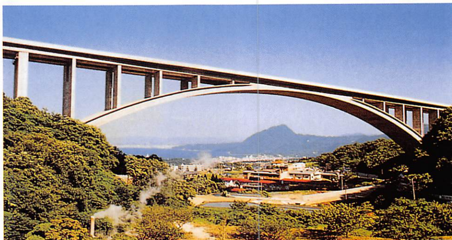
▲別府明礬橋(大分県) [別府の温泉地帯に架かる東洋一のRC固定アーチ橋で、強酸性の厳しい環境条件下で種々の防食対策が講じられている。]
