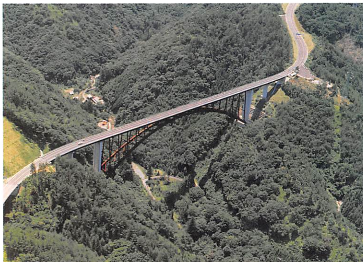
▲須佐大橋(山口県) [風光明媚なV字渓谷に架かる無塗装耐候性鋼材を用いた国内最大級の逆ローゼ橋。]
