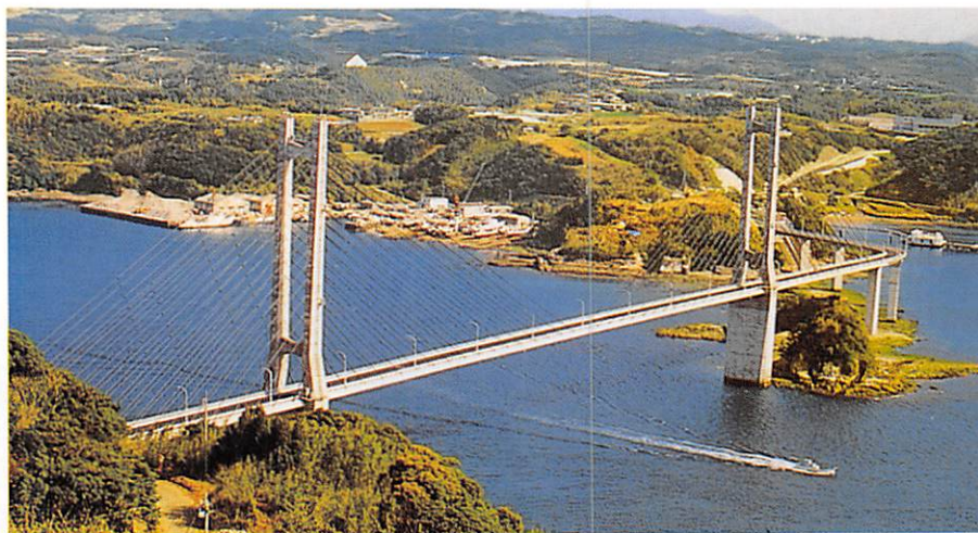
▲呼子大橋(佐賀県) [玄海国定公園内にある呼子と離島加部島を結ぶ主径間 250mの3径間連続PC斜張橋は、このクラスで日本一の規模を誇る。]
