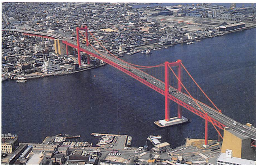
▲若戸大橋(福岡県) [28年ぶりにワイドにリフレッシュされたわが国最初の本格的吊橋。]
