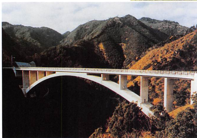
▲荒谷橋(山口県) [山口市宮野の荒谷ダムの玄関口として、深さ60mのV字谷を跨ぐ本県で初めてのR C固定アーチ橋。]
