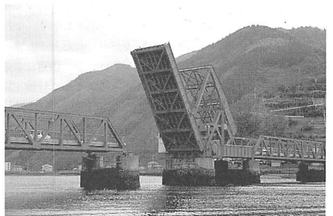
写真6 長浜大橋（愛媛県 1935）
