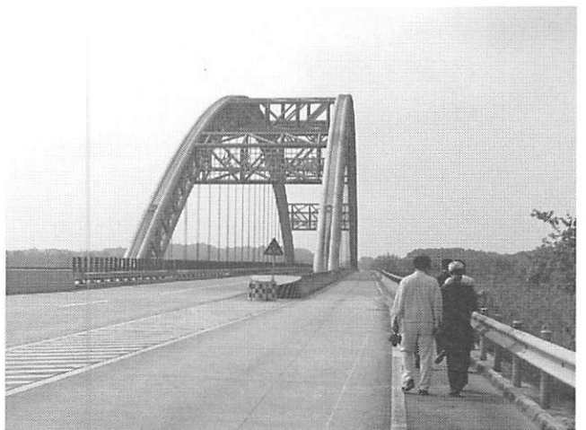
写真-4 中路CFTアーチ橋（南寧市、支間270m、1998年竣工）
