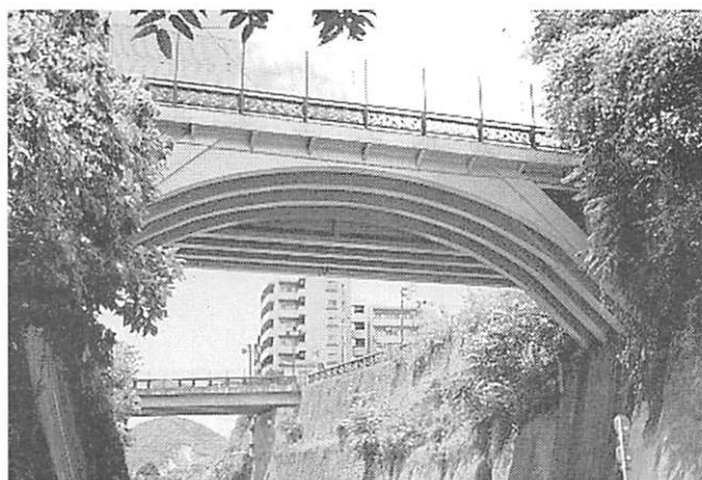
写真16 磐根橋(熊本県 1923)
