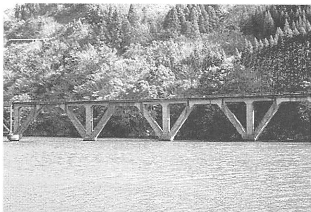
写真19 五ヶ瀬橋梁（宮崎県 1937）
