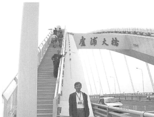
写真-3 盧浦大橋のアーチリブに設置された歩行者用階段
