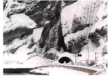
北海道トンネル崩落
