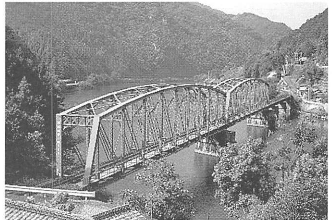
写真12 第一球磨川橋梁 (熊本県 1908)
