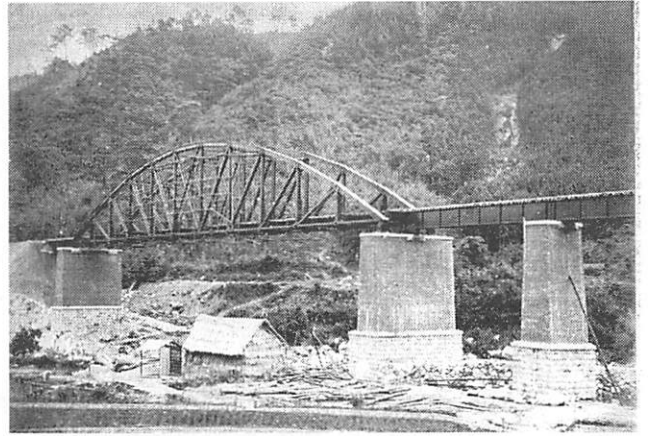
写真10 第二今川橋梁(福岡県 1895)(高田家所有)
