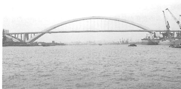
写真-2 盧浦大橋(上海市、支間550m、2003年竣工)
