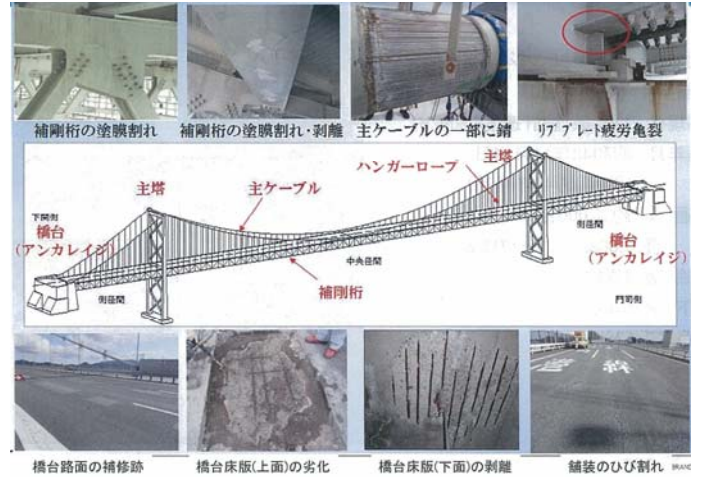
図 - 2. 関門橋の主な損傷状況
