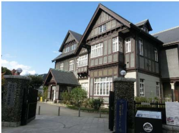
図-5. 重要文化財三井倶楽部
