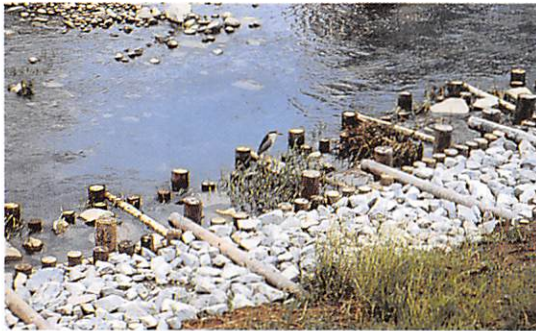
多自然型川づくり
