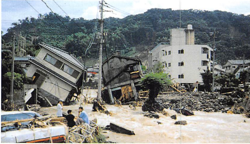
稲荷川の氾濫で傾いた家屋 (H. 5.8.6 豪雨, 鹿児島)
