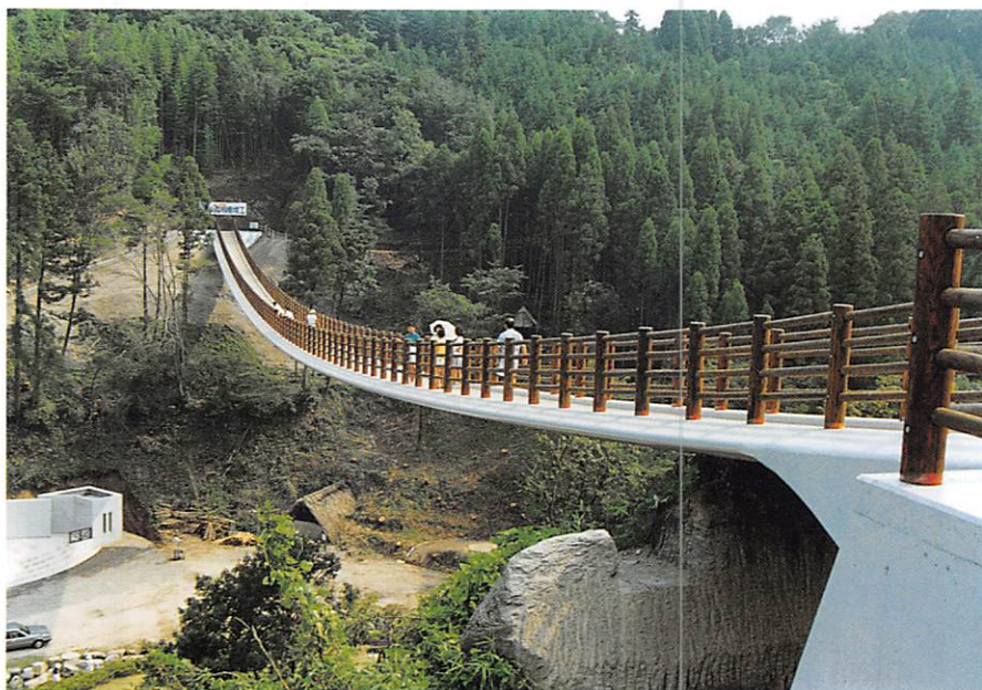
陣屋の森吊橋
