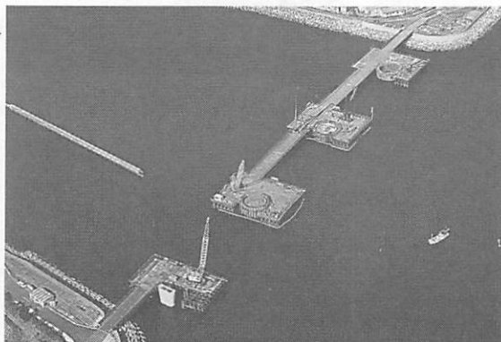
谷山臨海大橋工事現場
