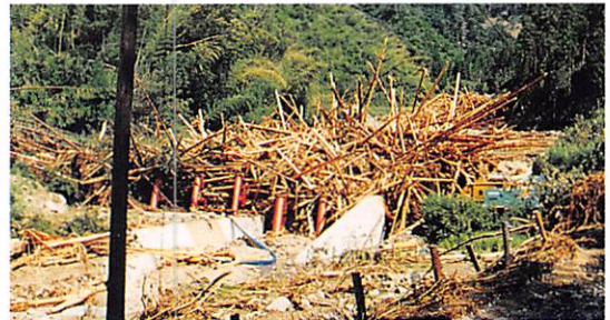
流木の流出をくい止めた流木止め工 (H. 5.9.3 台風13号山口水系屋形川、本耶馬溪町)
