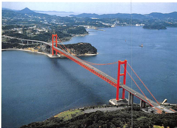
完成後の平戸大橋
