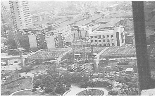
建設中の高架道路
