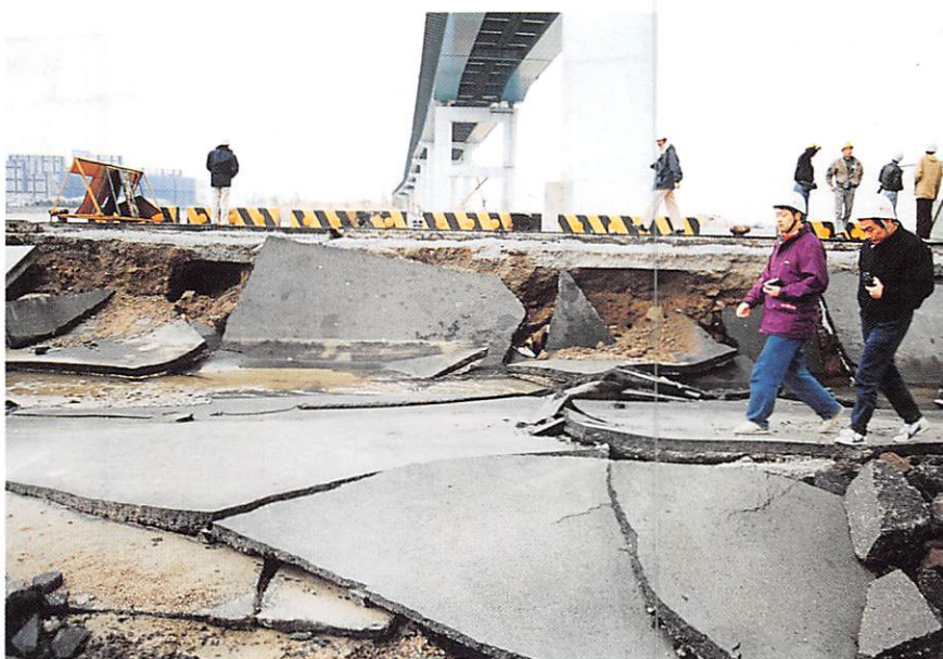
魚崎南岸壁の液状化に伴う地盤沈下
