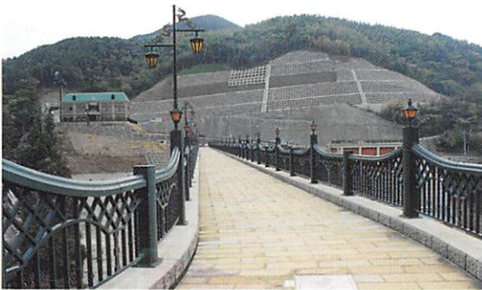
写真-1 ダム天端の高欄
