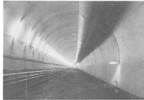
覆工コンクリート
