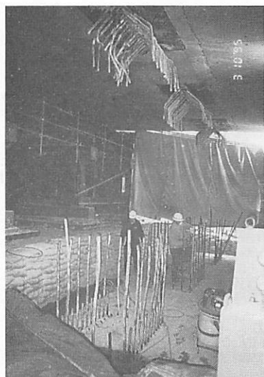
日本道路公団の復旧工事
