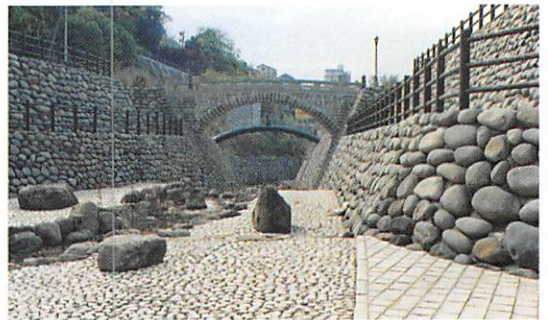
写真-2 ダム下流河川
