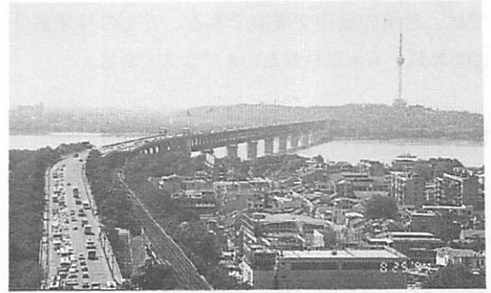
武漢長江大橋 L = 1670m, 1957年日ソ連の協力により完成 上路：道路、下路：鉄道の二階建
