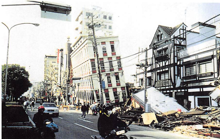
1階が圧壊して傾いたビル
