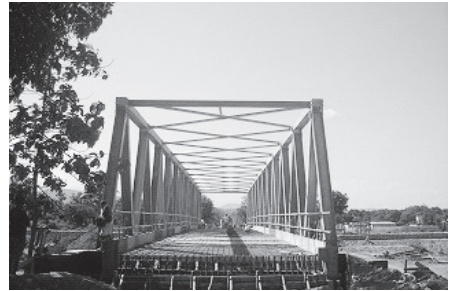
写真-24 建設中のカラウ・ウラング橋
