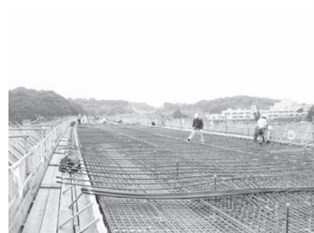
(3) 施工状況（中川橋）
