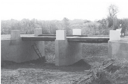
写真-28 ベスス橋
