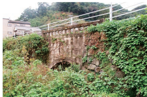
旧湯野田橋（湯野田橋上流に架かる）
