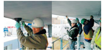
図-6 合成床版の非破壊検査
