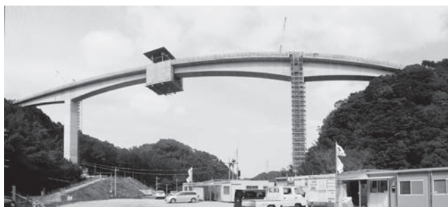
中央閉合部施工状況
