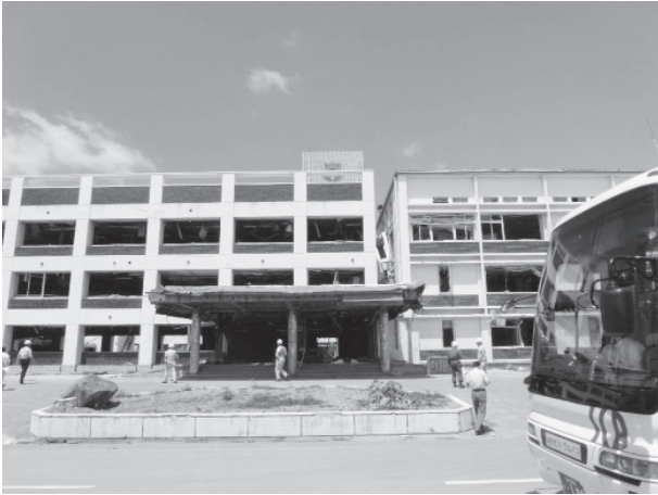
写真-1 被災した陸前高田市庁舎
