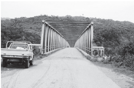
写真-25 ボボナロ橋
