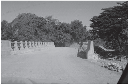
写真-22 ベ・モス橋
