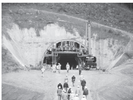
〔写真〕赤尾第三トンネル
