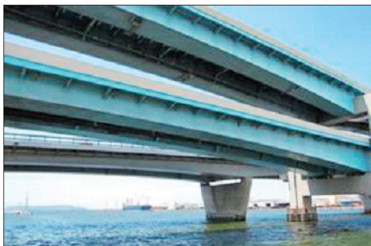
図-2 海岸線に並走する福岡高速1号線の橋梁
