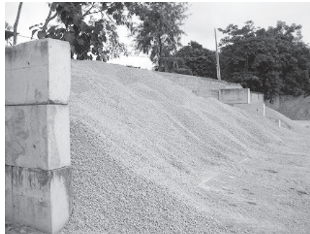
写真-20 屋根なしの骨材置き場
