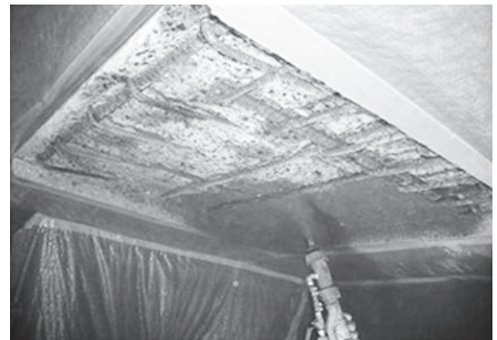
写真-4 コンクリート橋の桁端部の試験施工状況
