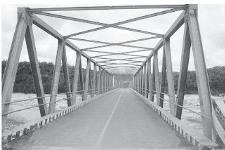
写真-31 アイアサ橋 (完成直後)
