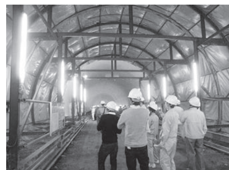
〔写真〕赤尾第三トンネル坑内
