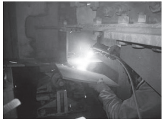
写真-3 試験施工の状況
