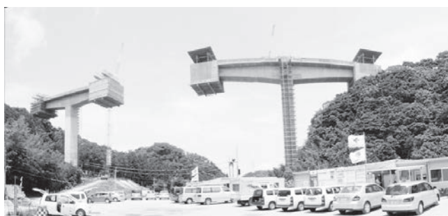
張出架設状況
