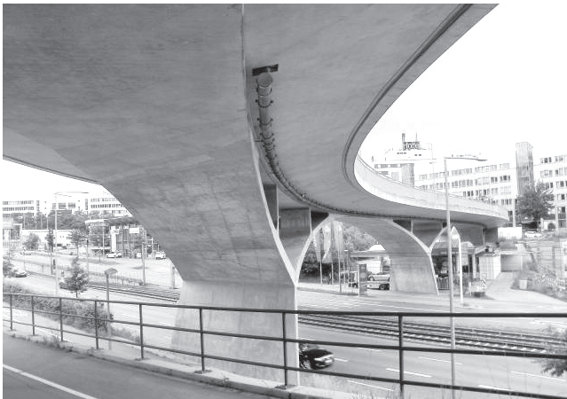
写真-13 Auerbach strasse橋
