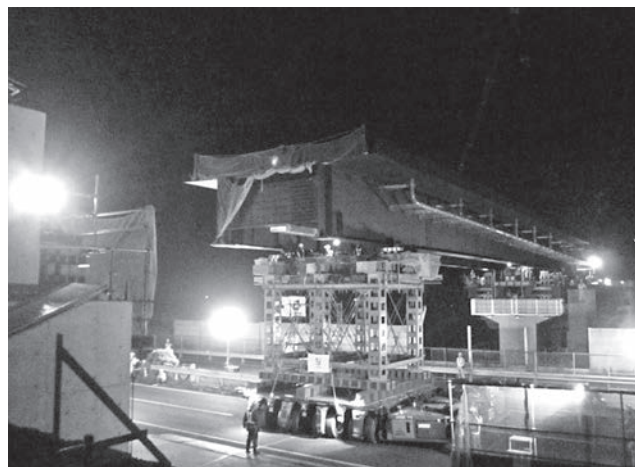
写真2 稲川高塚橋架設状況
