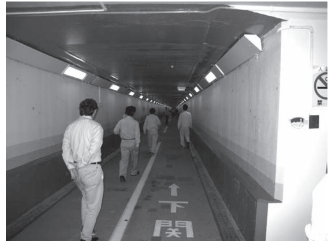
写真-5 関門トンネル人道
