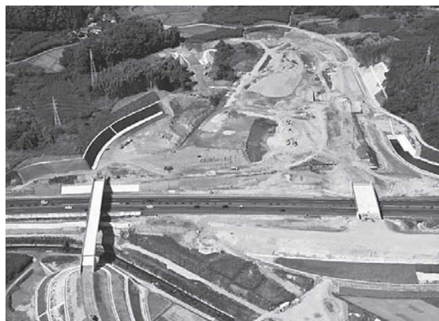
写真3 全景写真 (写真右がEランプ橋、左が稲川高塚橋)
