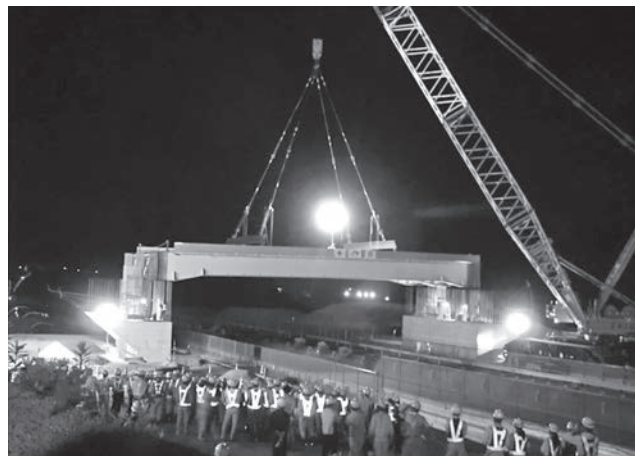
写真1 Eランプ橋架設状況
