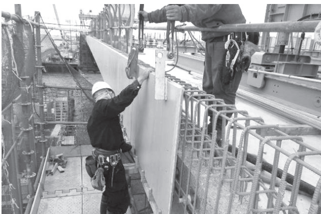
写真-4 埋設型枠設置状況
