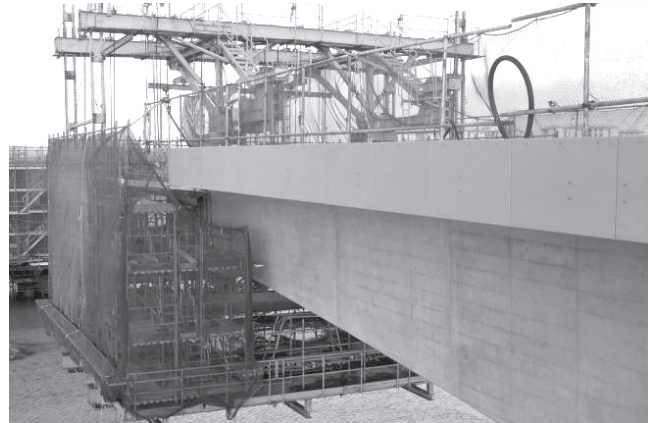
写真-5 埋設型枠設置完了
