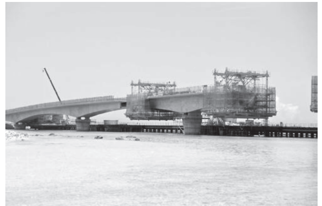
写真-2 張出し架設状況
