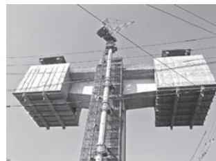
図-7 移動作業車の防護
