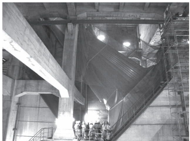
写真-2 関門橋アンカレイジ内部の見学
