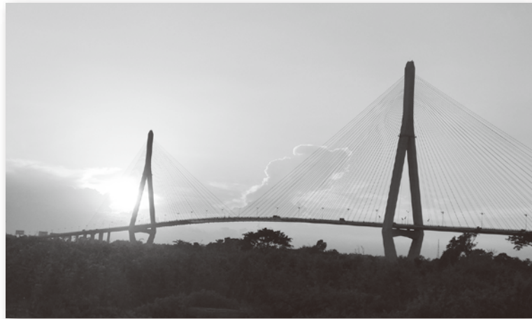
図-12 カントリー橋全景
