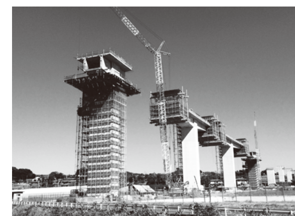
写真-1 起点側から望む
