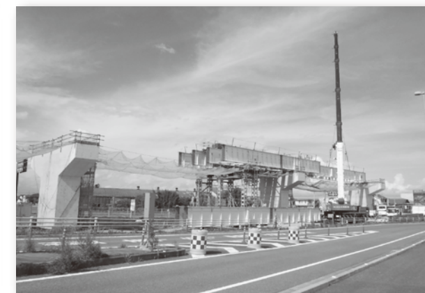
写真-1 桁架設状況
