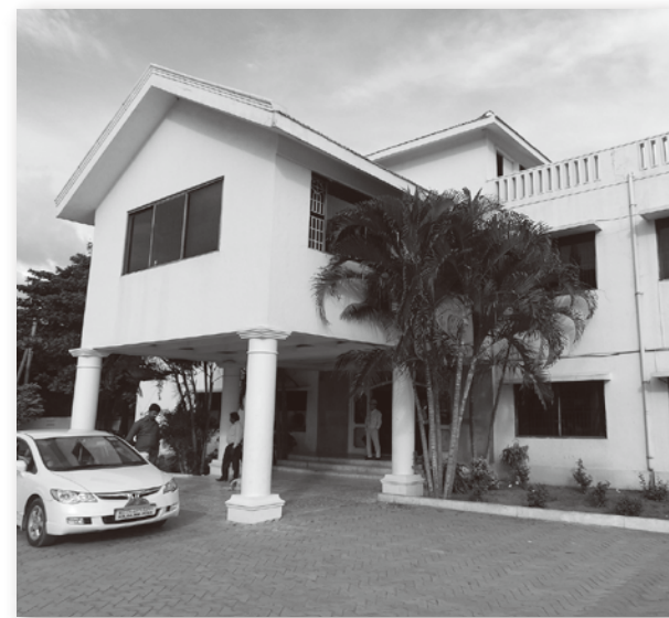
図-6 クラブハウス外観
