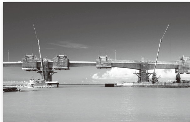
写真-2 施工状況
