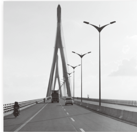
図-11 路面からの様子
