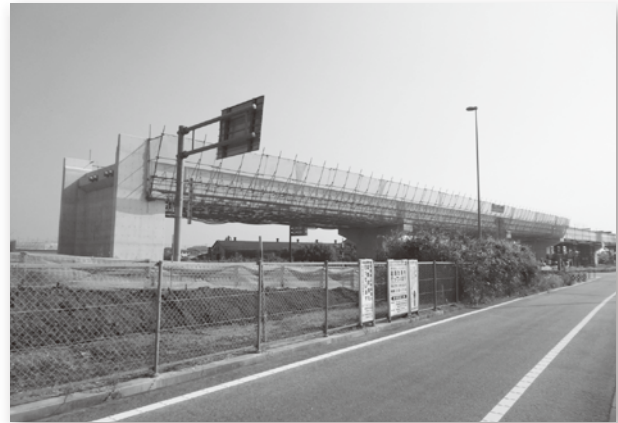
写真-2 桁架設置完了
