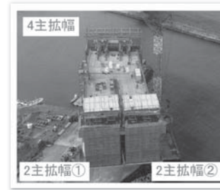
写真-1 移動作業車(P5張出)
