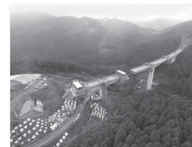
写真-2 平成29年9月末進捗状況
