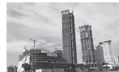
写真-2 建設中の高層ビル群
