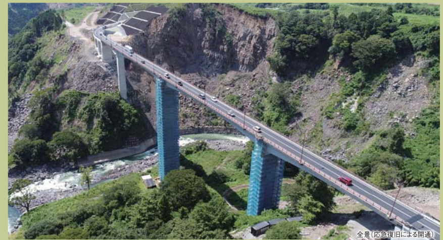
全景(応急復旧による開通)
