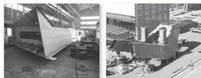
図-8 溶接状況と仮組立状況
