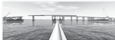
図-7 送出し架設イメージ図
