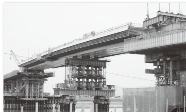
写真-5 桁降下全景写真
