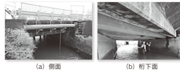
(a) 側面 (b) 桁下面
