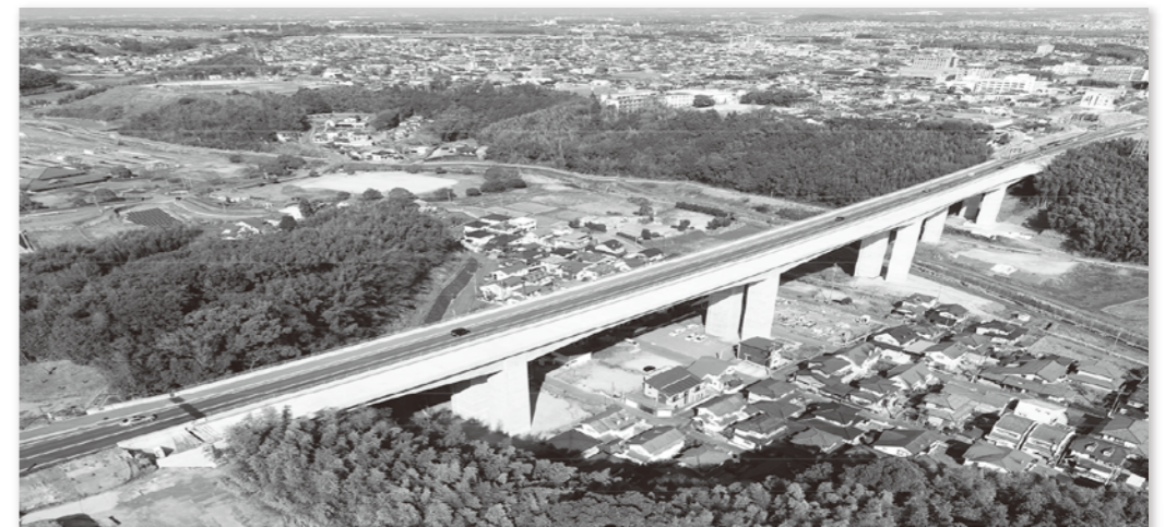
写真-1 完成写真
