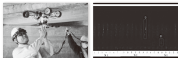
写真-3 点検状況
