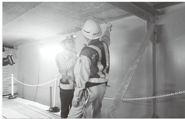
写真-6 現場レポート状況
