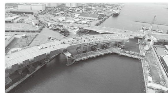
図-2 福岡高速6号 施工状況航空写真
