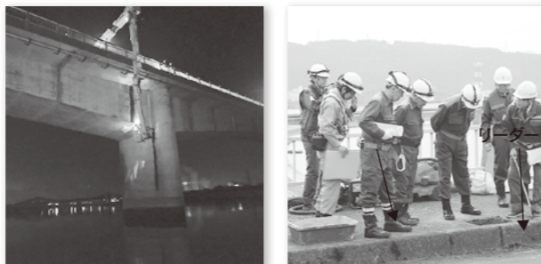
写真-1 直轄点検状況
