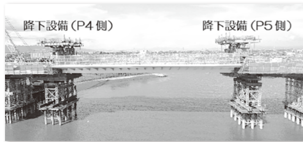
写真-3 桁の降下完了
