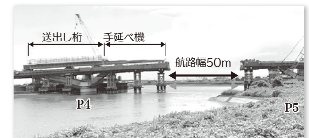
写真-1 送り出し架設前
