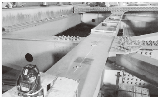
写真-4 レーザー墨出し器使用状況
