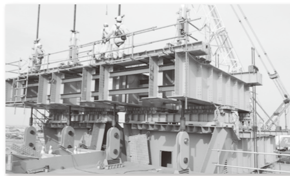
写真-4 桁降下施工状況
