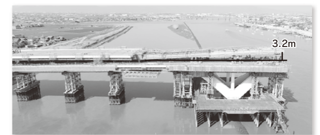
写真-1 手延べ機連結部の仰角
