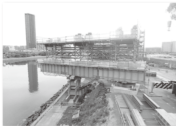
図-7 片持ち梁ベント構造
