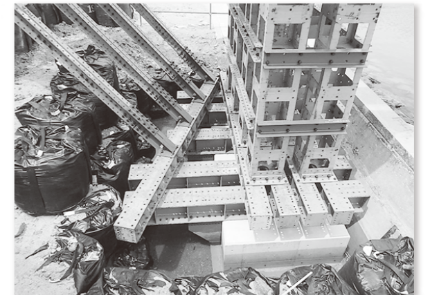
図-3 ベントコンクリート基礎写真
