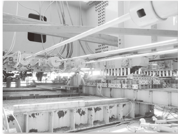
写真-2 送出し施工状況
