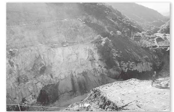
写真-8 掘削現場
