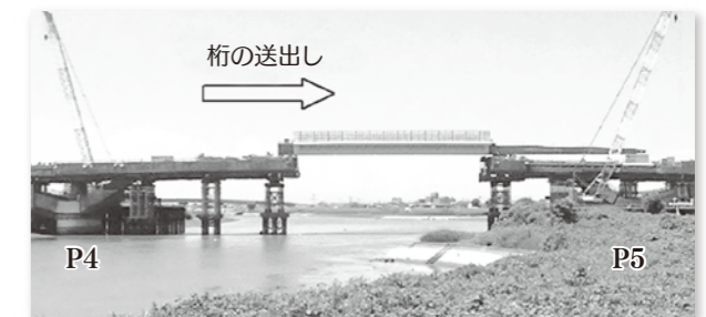
写真-2 送り出し完了
