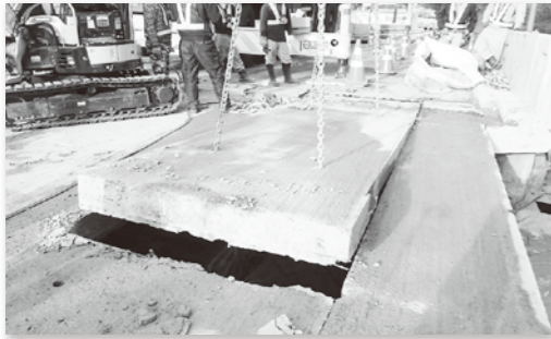
写真-2 合成桁部の既設床版撤去状況
