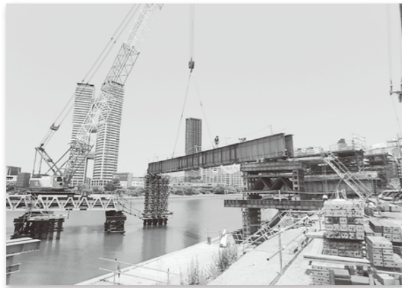
図-5 基礎杭と工事桁を併用した構造
