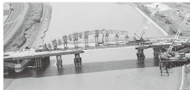
写真-5 アーチリブの架設状況
