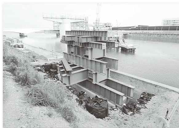
図-8 ベント基礎 ピラミッド形状
