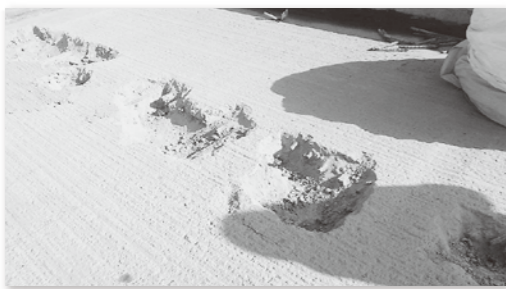
写真-3 スラブアンカーはつり出し状況
