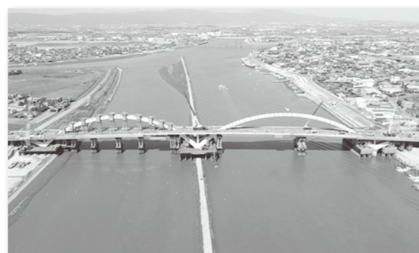
写真-6 現地架設状況
