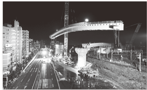
写真-3 架設状況(上り線)
