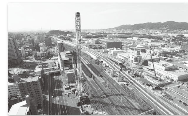
写真-1 クレーン配置状況
