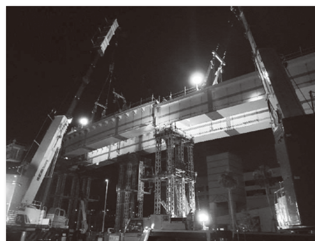
写真-5 桁架設
