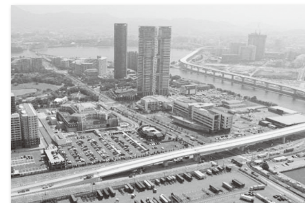
写真-1 福岡高速6号線 写真 (アイランドシティ出入口付近)
