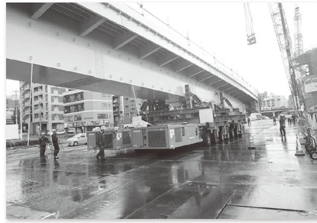
写真-2 桁移動
