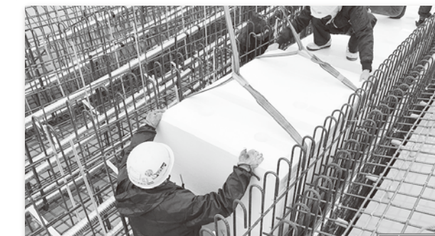
写真-3 ポイド設置状況
