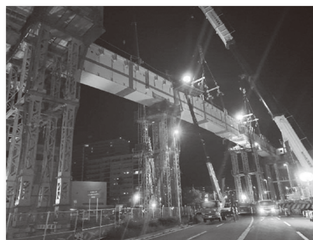
写真-4 桁架設
