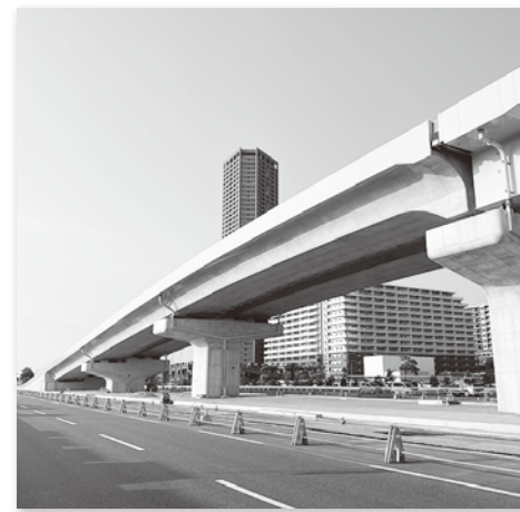
写真-2 完成写真(近景)
