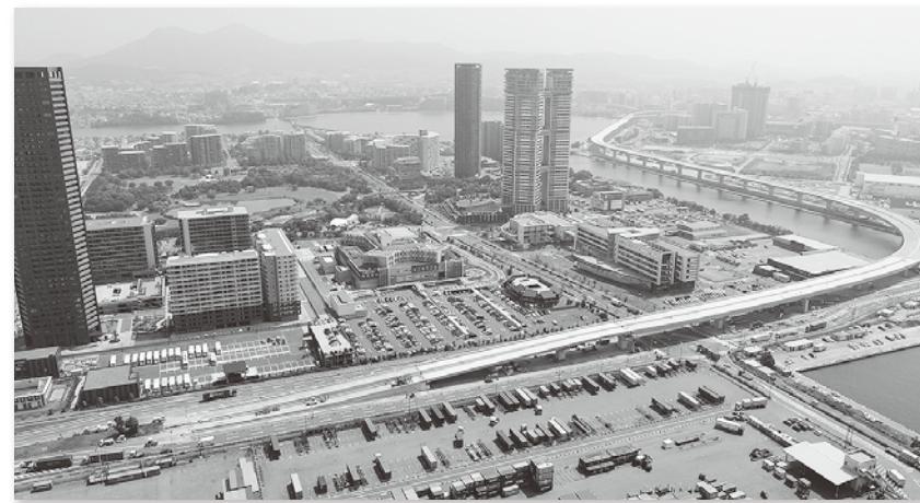
写真-1 完成写真(全景)
