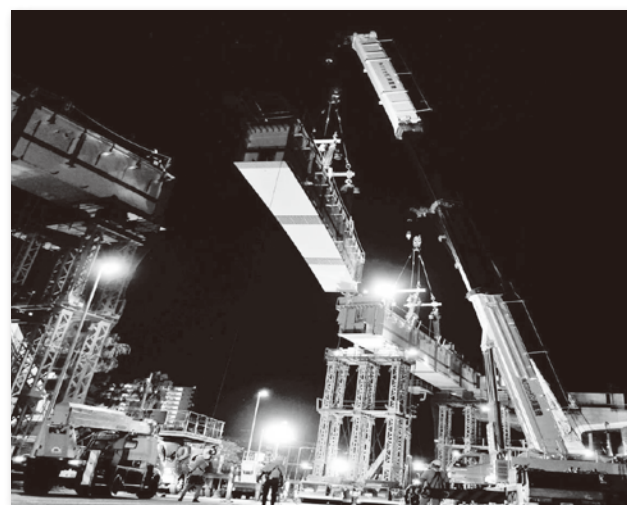
写真-3 桁架設
