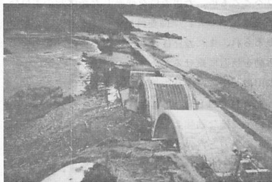
甌2号橋建設予定地
