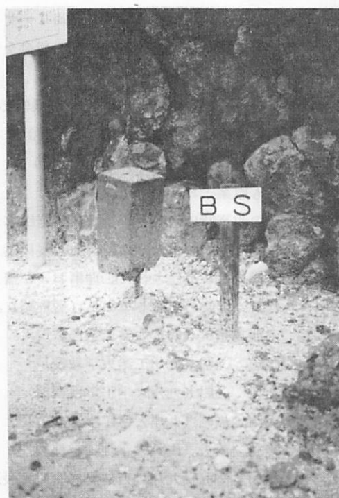
暴露試験供試体の温泉腐食
