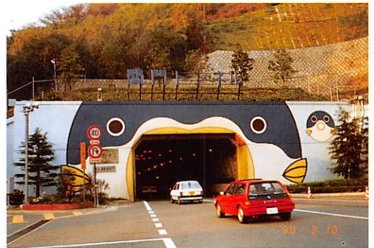
関門国道トンネル門司側入口
