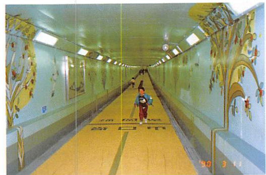
現在の関門歩道トンネル
