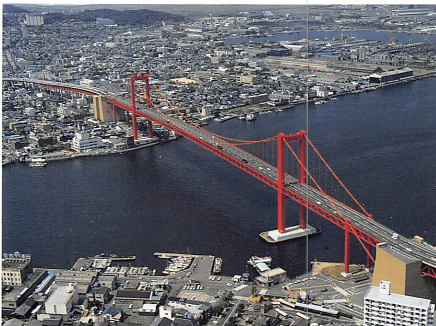
若戸大橋 (平成2年度土木学会技術賞受賞)
