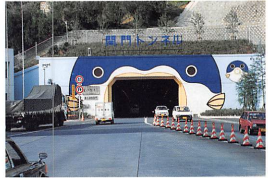
関門国道トンネル 門司側入口
