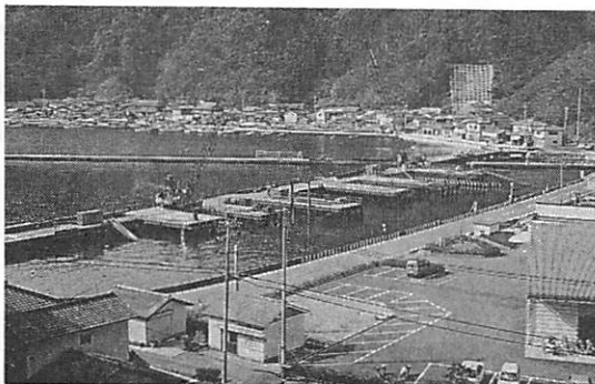
下部工施工中
