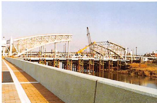
アーチリブの解体作業
