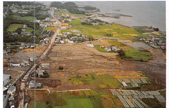
国道251号線付近の土石流氾濫状況
