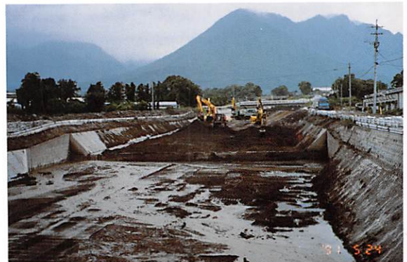
水無川における土石流堆積土砂の除去作業
